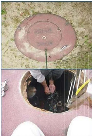
・生駒市水道局と記載がある方の下側の穴にマンホールキーのT字型になっている方を差し込む。
